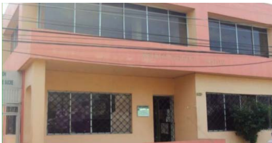
Foto 2. Fachada de la Biblioteca pública departamental. Fuente: Elaborada por autores de este trabajo.
