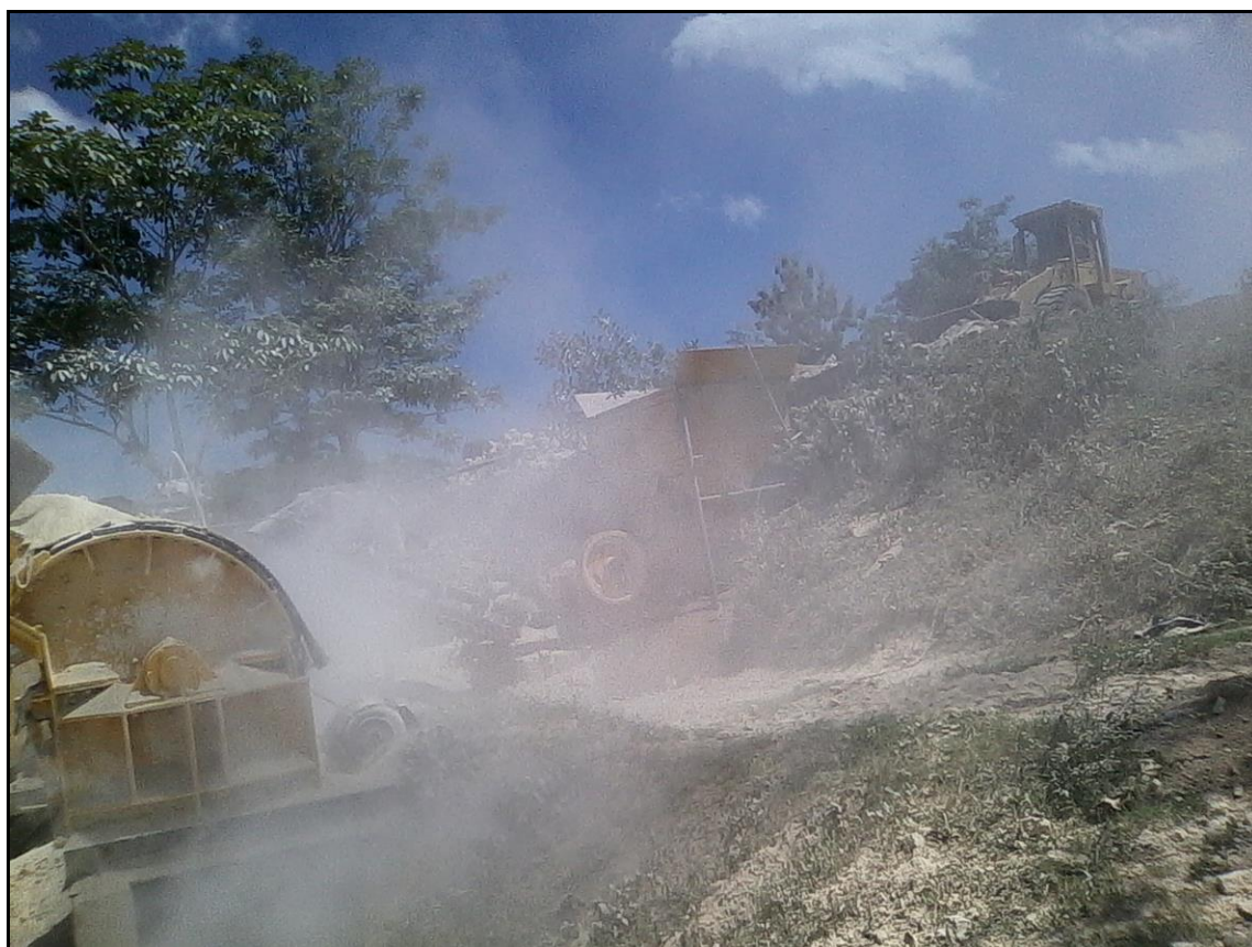
Figura 22. Material particulado de caliza y uso de maquinaria pesada.
