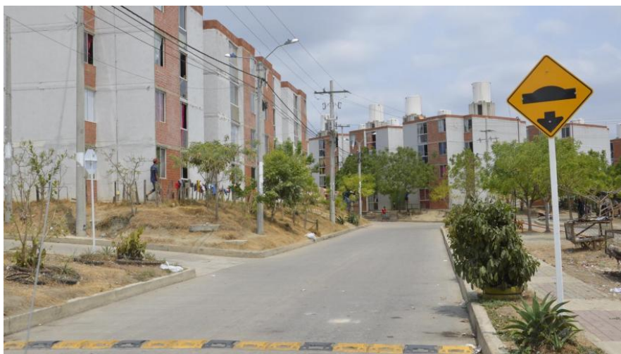
Figura 40. Estado actual de las vías, en la primera etapa de altos de la sabana. Fuente: El heraldo. 2019
