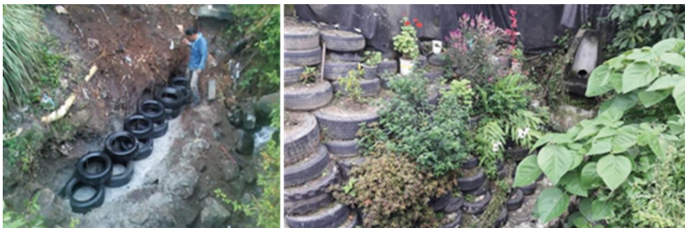
Imagen 2. Proceso de construcción de muro de protección en llantas usadas.
