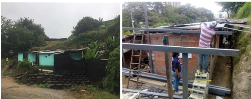
Imagen 3. Construcción de mejoramiento de vivienda en el Tesoro.
