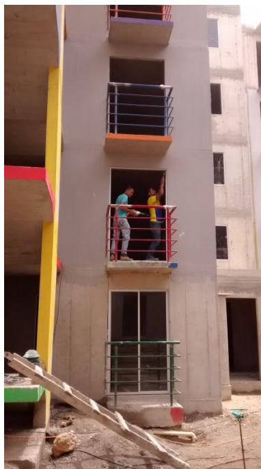
Ilustración 9. Instalación marco puerta ventana
