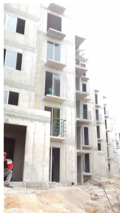
Ilustración 12. Verificación de instalación
