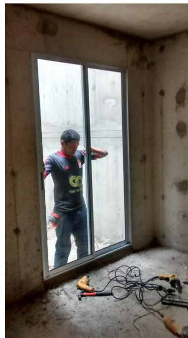
Ilustración 7. Verificar riel de puerta ventana
