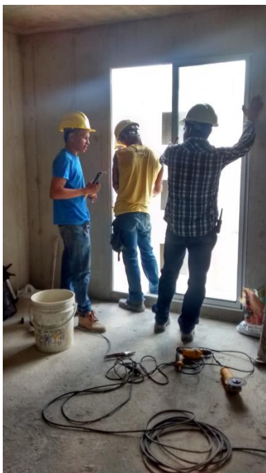
Ilustración 8. Atornillar marco puerta ventana
