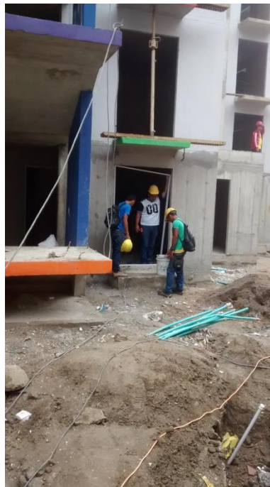
Ilustración 5. Verificación marco puerta ventana.
