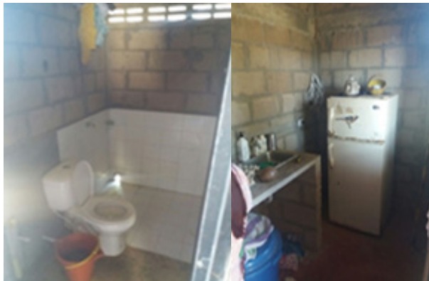
Imagen 17, 18, 19, 20. Tipología de vivienda de interés prioritario, materiales constructivos de bloque de cemento, concreto y acero. Baño y cocina.
