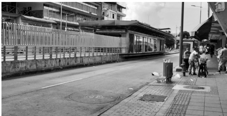
Imagen 30. Transformación del Espacio Público por el Transporte Masivo Metrolinea.
