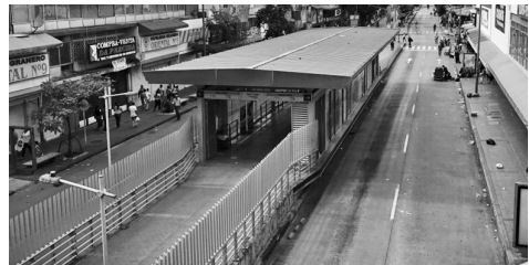
Imagen 31. Transformación del Espacio Público por el Transporte Masivo Metrolinea.
