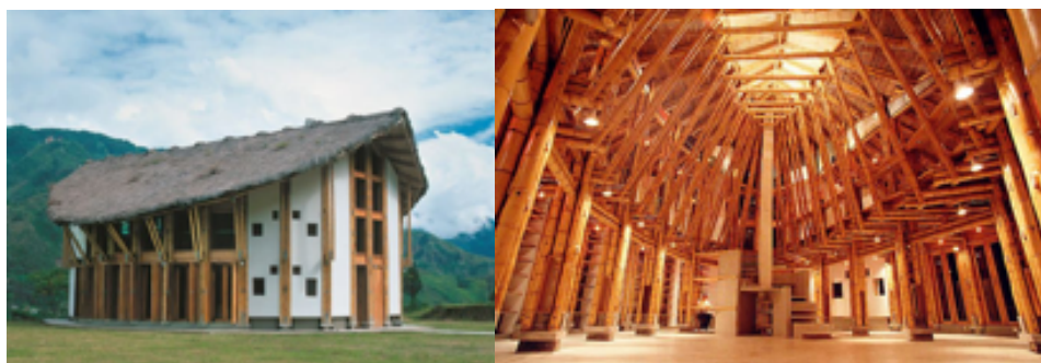
Imagen 5. Biblioteca Casa del Pueblo
