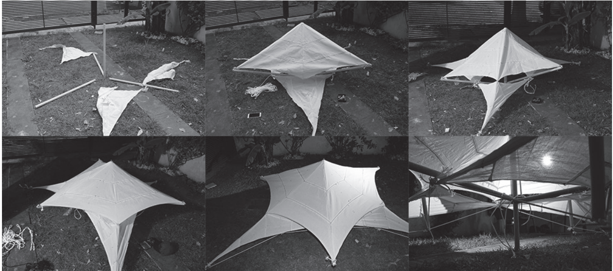
Figura 12. Proceso de montaje de la estructura. Fuente: Mercado Escandón J. Abraham, diciembre 2018.
