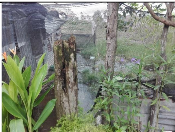
Foto 10. La imagen muestra el estado actual de los patios de las viviendas del sector el Guerrero de Tolú.
