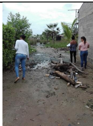
Foto 11. Estado actual de los patios de las viviendas del sector el Guerrero de Tolú.
