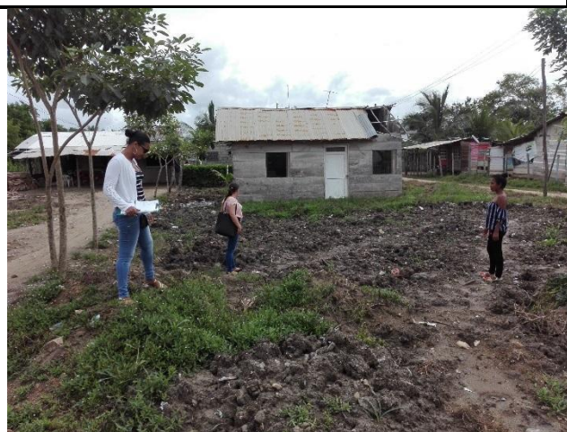
Foto 13. Estado actual de los patios de las viviendas
