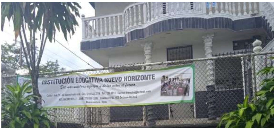
Foto 1. Instalacion Institucion Educativa Nuevo Horizonte.
