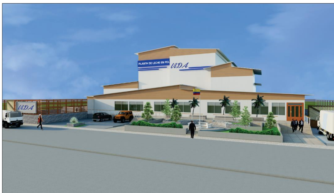
Figura 49 Vista Lateral Derecha de la Fachada
