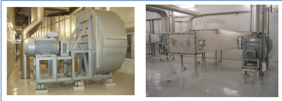
Figura 26 Disposición Característica del Sistema de Ventilación y Presurización
