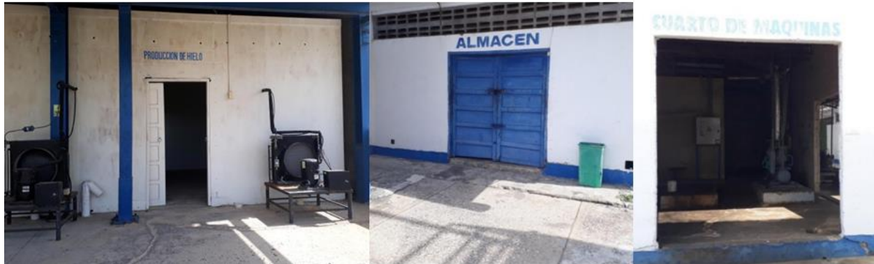
Figura 10. Área de producción de hielo, almacén y cuarto de máquinas. Tomado de Empresa Colombiana pesquera de Tolú S.A. Pestolú, 2017.
