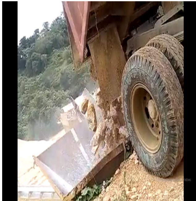
Figura 20: Descargue del material.
