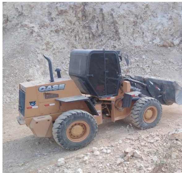
Figura 15: Maquina para la eliminación o remoción del material estéril.
