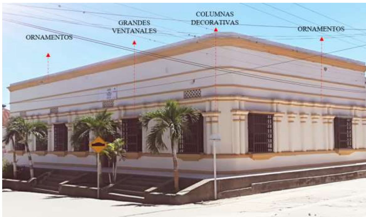
Imagen 26: Detalles diferenciales de la fachada de la edificación.
