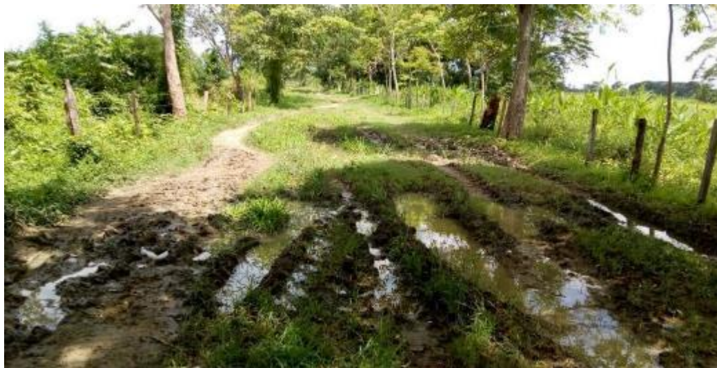
Imagen 3. Acceso en mal estado vereda Tosnovan, municipio de San Benito Abad.
