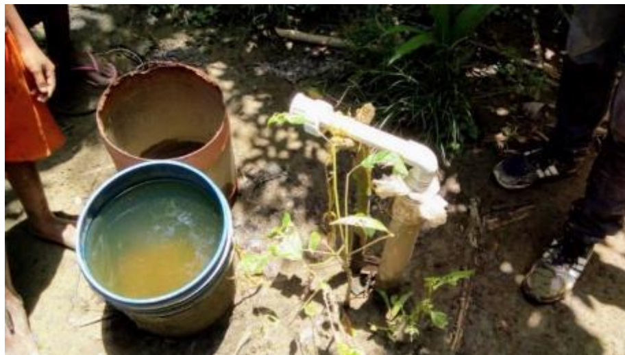
Imagen 1. Perforación para abastecimiento de agua vereda Tosnovan, municipio de San Benito Abad.
