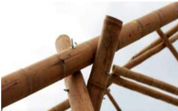
*Ilustración 8*, La casa ensamble chacarra (estructura en guadua)
