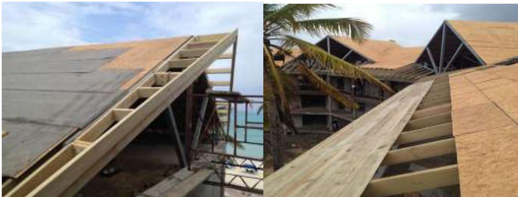
*Ilustración 5*, Cubierta en madera aglomerada, fuente: <https://www.arquitecturaingenieria.net/estructuras-en-madera/cubiertas-de-madera/>
