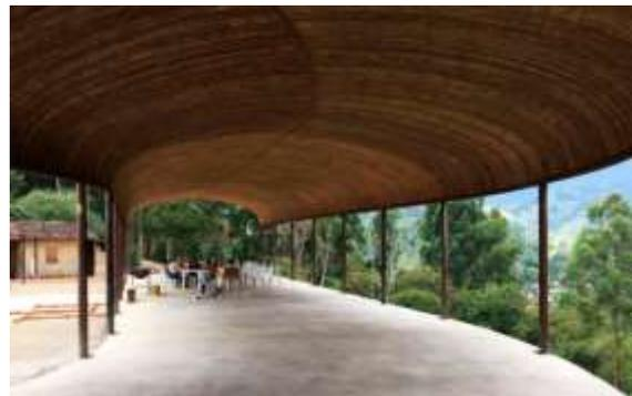
*Ilustración 9*, Residencia privada en Manizales (cubierta en bambú) <https://www.archdaily.co/co/896067/el-bambu-colombiano-segun-simon-velez-y-marcelo-villegas-montajes-conexiones-y-soportes-estructurales/5b2bb4c1f197ceb76c000347-el-bambu-colombiano-segun-simon-velez-y-marcelo-villegas-montajes-conexiones-y-soportes-estructurales-foto>
