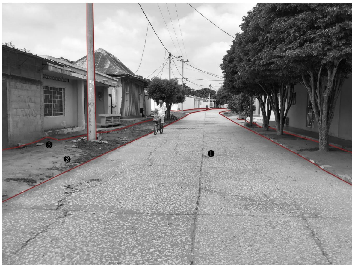
Ilustración 48. fotografía y análisis del estado actual de la carrera 5- Elaborado por el grupo de trabajo.
