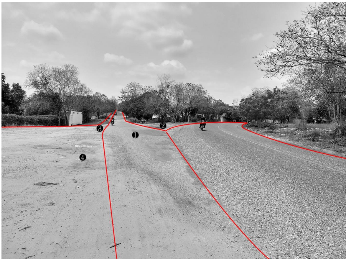
Ilustración 46. Fotografía y análisis del estado actual de la carrera 5- Elaborado por el grupo de trabajo.
