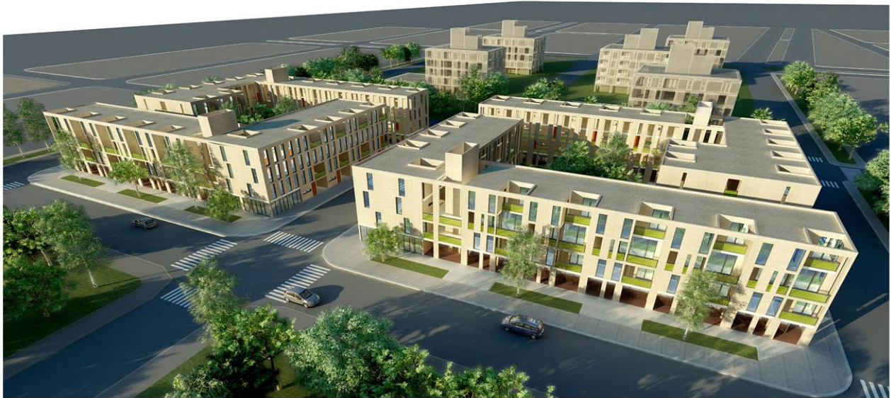
Imagen 65. Edificios de viviendas PRO.CRE.AR.
