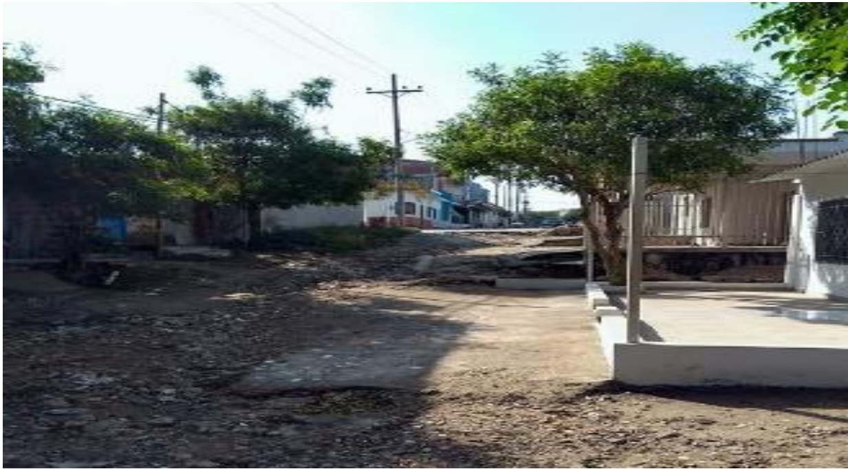
Imagen 31. Vías urbanas en mal estado – Carrera 6h.
