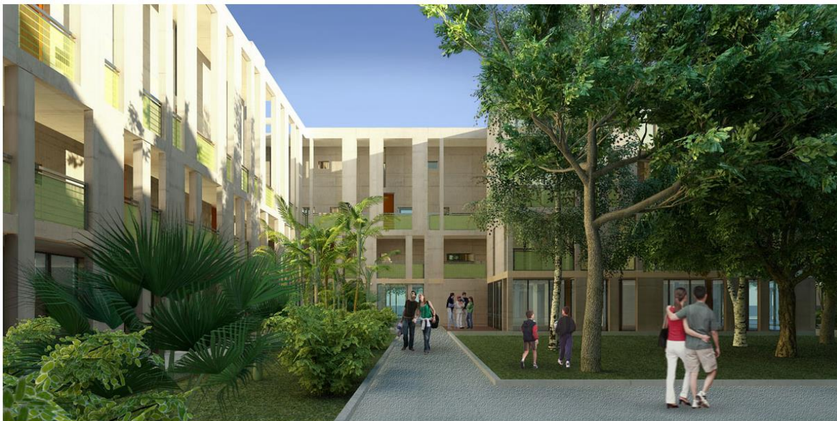
Imagen 66. Edificios de viviendas PRO.CRE.AR.
