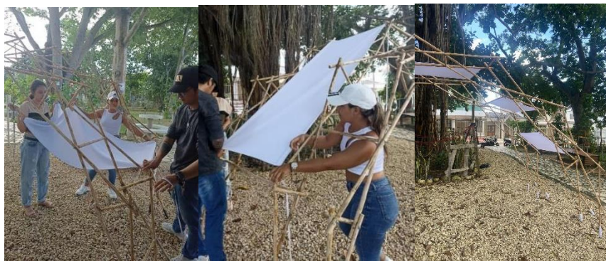
Instalación de Cubierta
