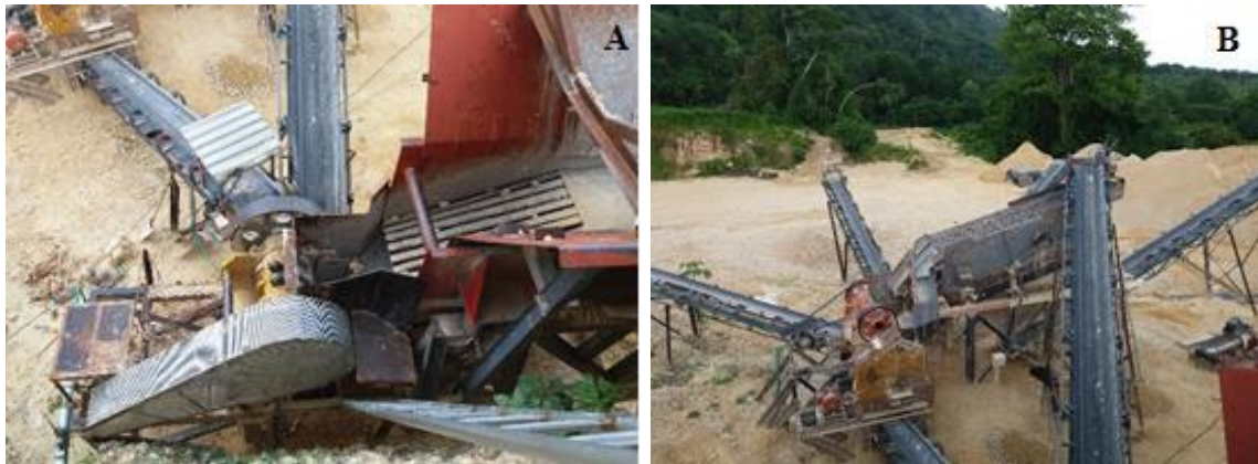
Figura 14. Planta de trituración y clasificación de materiales agregados. Municipio de Tolviejo – Sucre. Fuente: Elaboración propia 2017.
