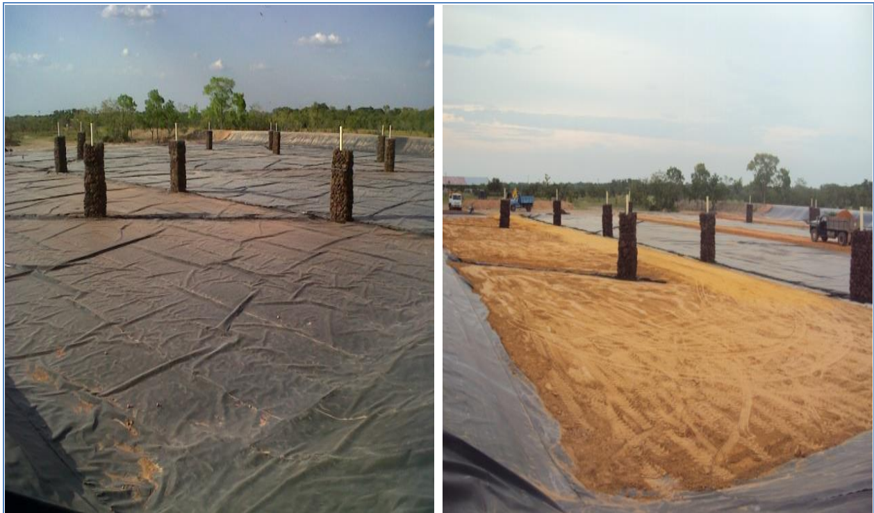
Figura 19. Primera celda de relleno sanitario, chimeneas y geomembrana
