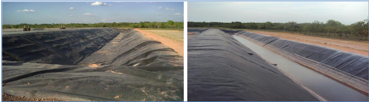
Figura 20. Piscina de lixiviado del relleno sanitario
