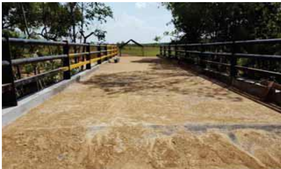
Figura 11. Construcción puente El Avioncito
