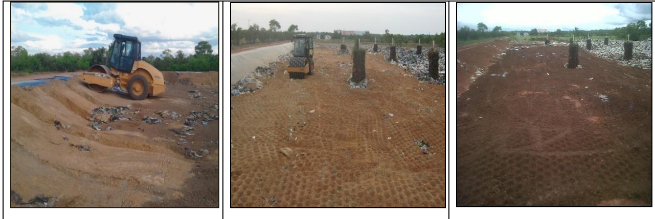
Figura 21. Operación del relleno sanitario
