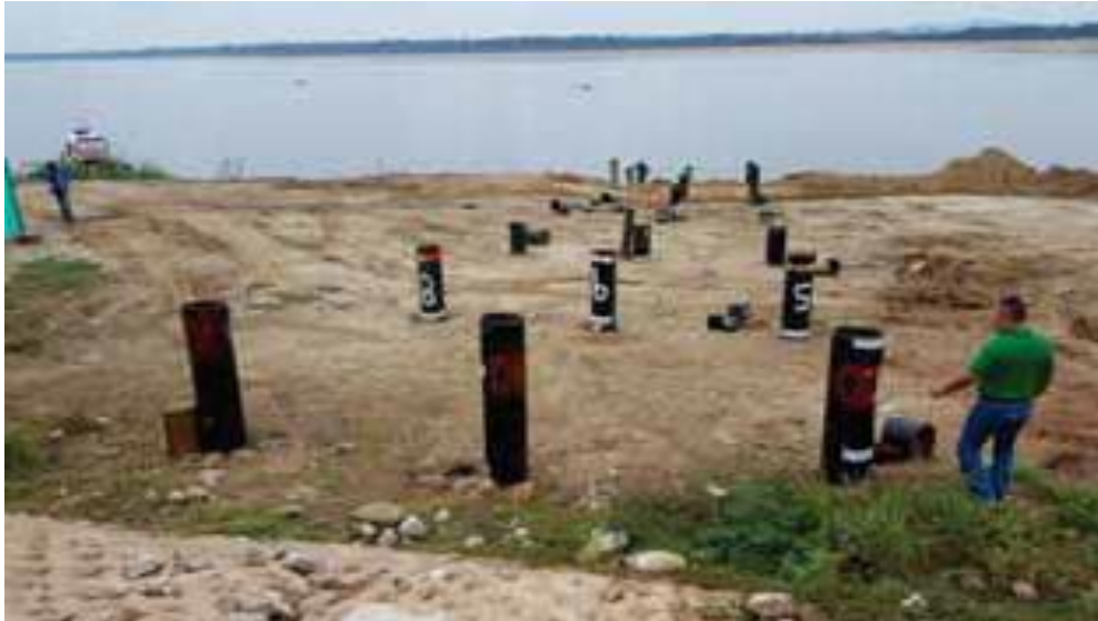
Figura 10. Construcción muelle de Puerto Carreño – tercera etapa
