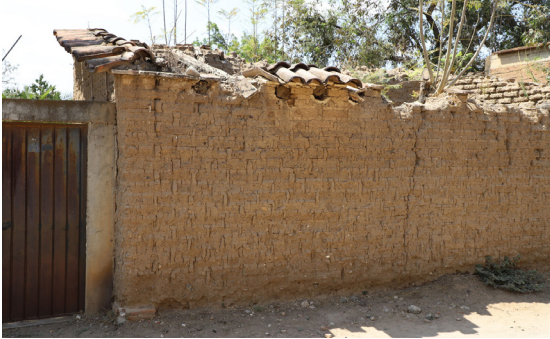
Figura 14. Vivienda con características de arquitectura vernácula con adobe, en ruinas. Fuente: Autores. Año 2020.
