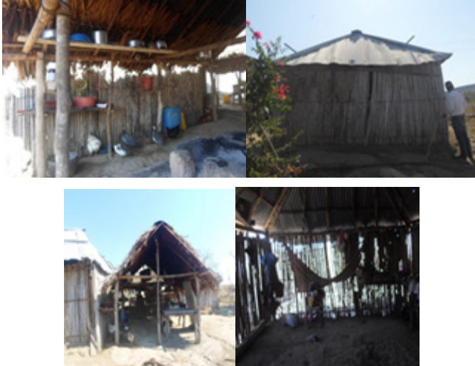
Imagen 21, 22, 23, 24, 25. Tipología de vivienda de palma y bahareque. Módulos funcionales: cocina, zonas de estancia.
