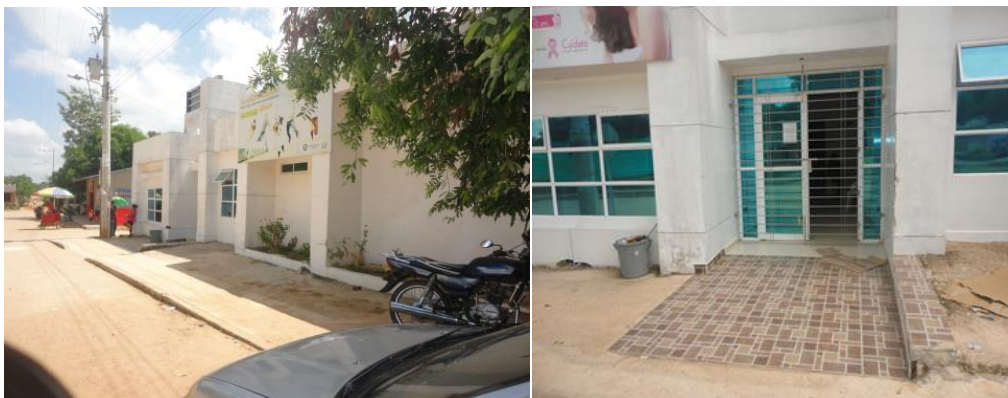
Figura 4. Fachada Centro de Salud El Roble
