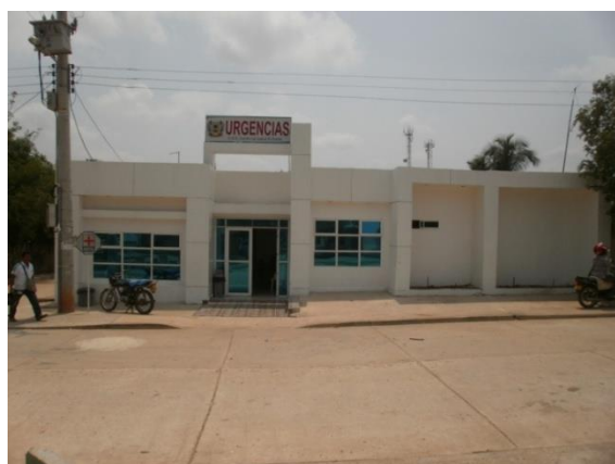
Figura 3. Fachada del Centro de Salud
