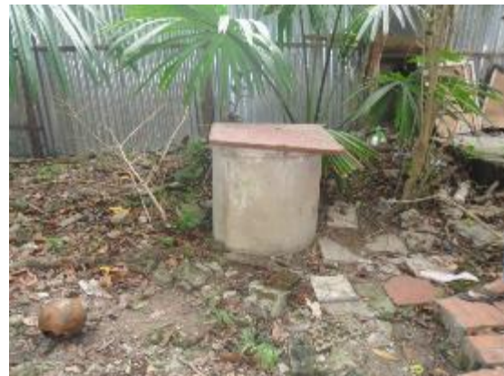
Imagen 48: Pozo llorado Fuente: Iglesia, Mendivil & Monterroza
