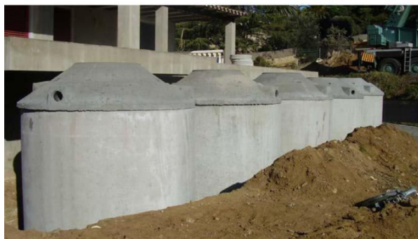
Imagen 8: Depósitos de Hormigón Tomado de: Arsys
