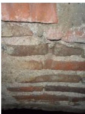
Imagen 97: Detalle de Materiales del aljibe Fuente: Iglesia, Mendivil & Monterroza
