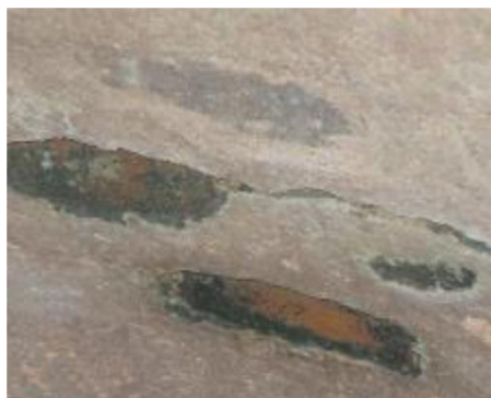
Imagen 75: Detalle de Materiales del aljibe Fuente: Iglesia, Mendivil & Monterroza
