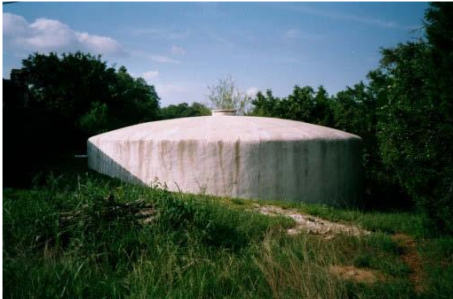
Imagen 6: Tanque Semienterrado en Ferro – cemento Tomado de: The Texas on Rainwater Harvesting. 2005
