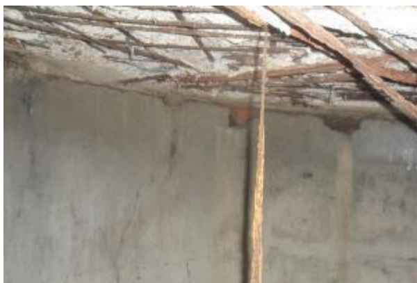
Imagen 250: Detalles de materiales aljibe Flia. Turbai Fuente: Iglesia & Mendivil
