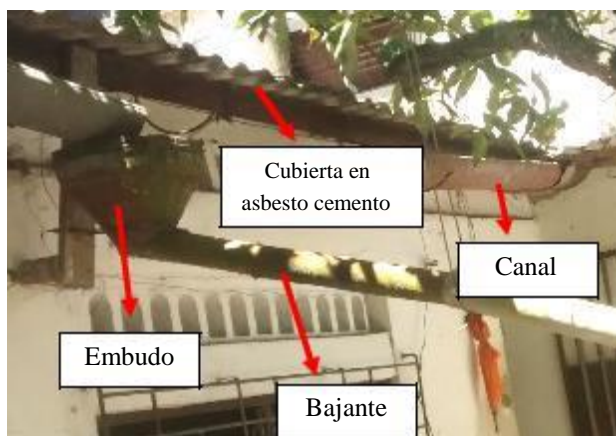
Imagen 245: Elementos en lámina galvanizada Aljibe Flia Echeverri Fuente: Iglesia & Mendivil
