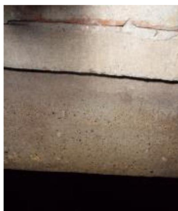
Imagen 56: Detalle de Materiales del Aljibe Fuente: Iglesia, Mendivil & Monterroza
