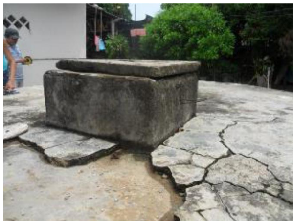
Imagen 32: Detalle Constructivo del aljibe Fuente: Benítez, Iglesia & Mendivil
