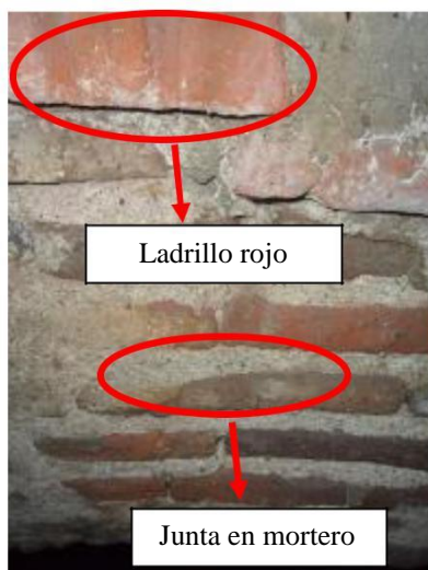
Imagen 248: Detalles de materiales aljibe Flia. Turbai Fuente: Iglesia & Mendivil
