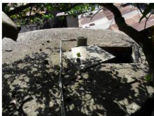
Imagen 111: Detalle de Materiales del aljibe Fuente: Benítez, Iglesia & Mendivil
