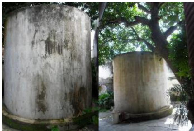
Imagen 175: Aljibe desde el patio y la cocina Fuente: Iglesia, Mendivil & Monterroza
