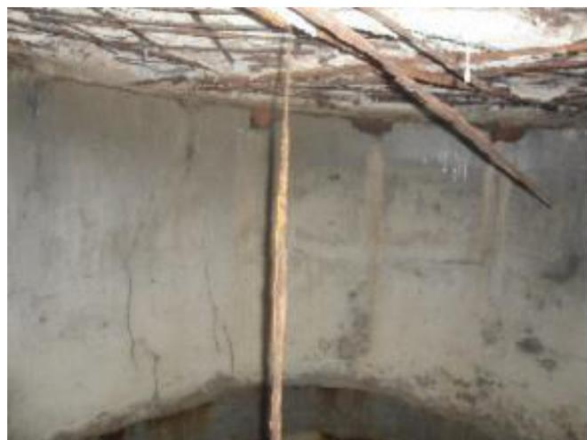
Imagen 39: Detalle Constructivo de la tapa Fuente: Iglesia, Mendivil & Monterroza
