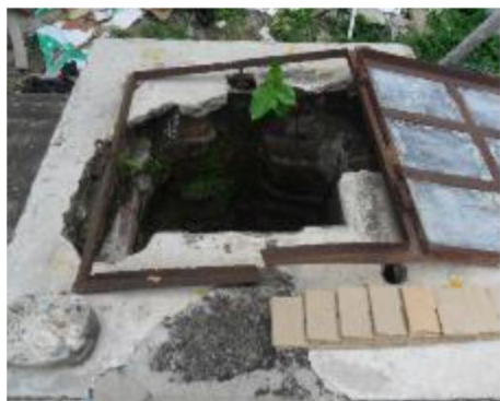
Imagen 209: Entrada del aljibe Fuente: Benítez
