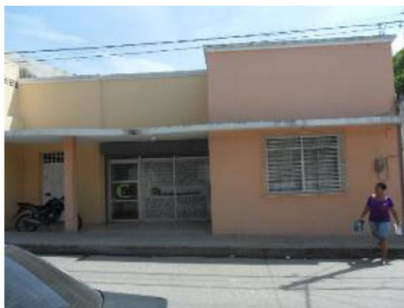
Imagen 150: Fachada casa Familia Gómez Fuente: Iglesia, Mendivil & Monterroza
