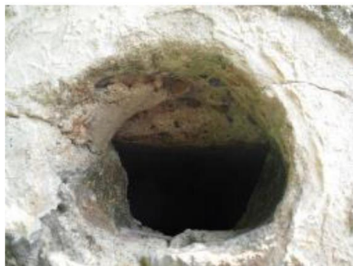
Imagen 146: Detalle de Materiales del Aljibe Fuente: Benítez, Iglesia & Mendivil
