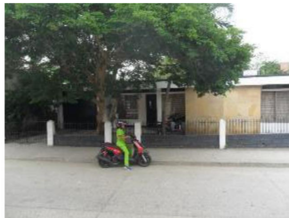
Imagen 43: Fachada Casa Familia Turcios Seva Fuente: Iglesia, Mendivil & Monterroza
