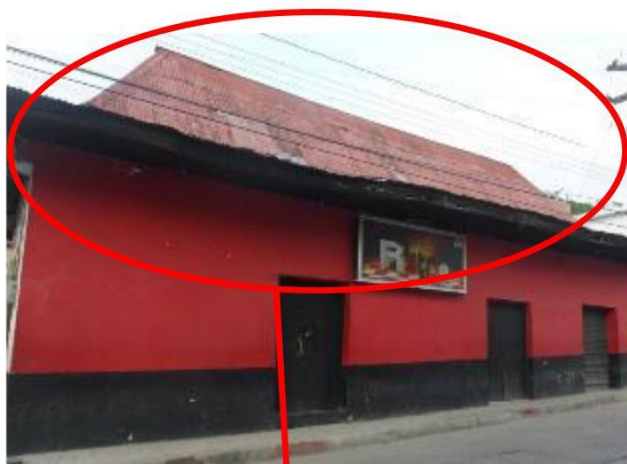
Cubierta en Zinc
