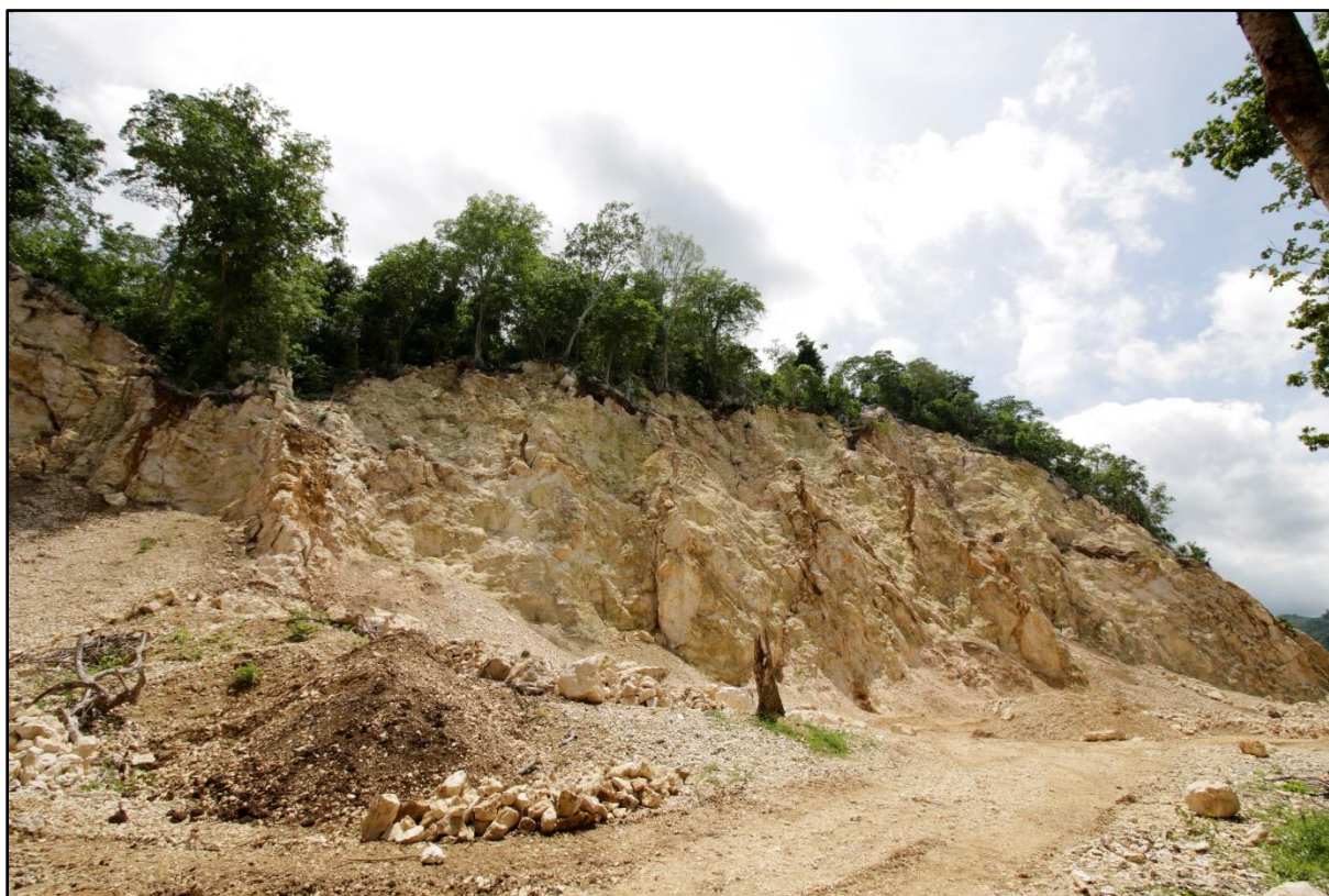
Figura 23. Destrucción del relieve y descapotado de la cubierta vegetal.
