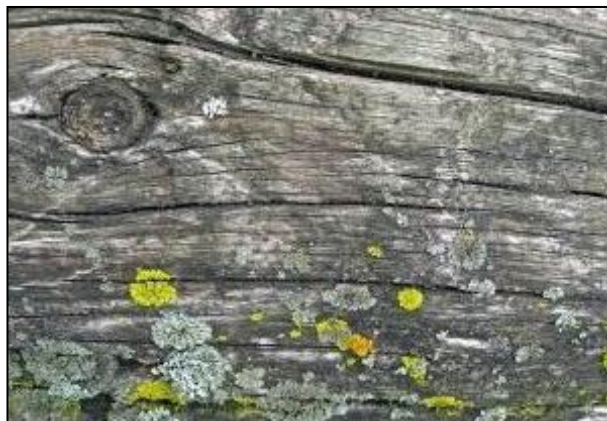
Figura 93. Presencia de hongos en madera. Fuente de elaboración Garrido, M. (2015).
