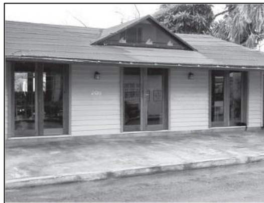
Figura 17. Vivienda que funcionaba como restaurante. Fuente de elaboración Pérez, J. (2009).
