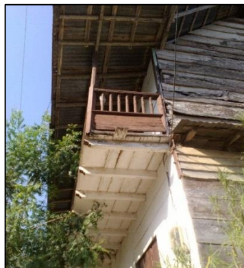
Figura 42. Detalles del balcón de la vivienda. Fuente de elaboración propia (2017).
