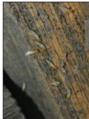
Figura 94. Presencia de termitas en madera. Fuente de elaboración Garrido, M. (2015).
