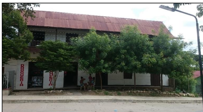
Figura 1. La Vivienda de Miguelina Febles, donde se aprecia su fachada principal en aparente “buen estado”. Fuente de elaboración propia (2017).
