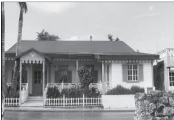
Figura 16. Vivienda que funcionaba como restaurante. Fuente de elaboración Pérez, J. (2009).
