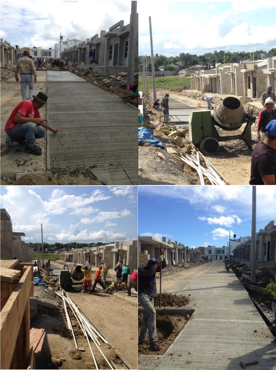
Fundición de Calle 1, tramo 2. Urbanización Santa Catalina Etapa 6.
