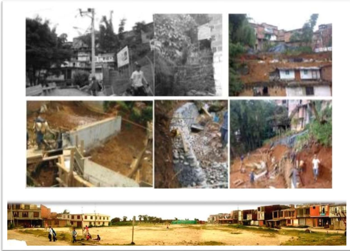
Ilustración 4. Mitigación del riesgo estructural de la vivienda y estabilización del suelo por medio de muros de contención.
