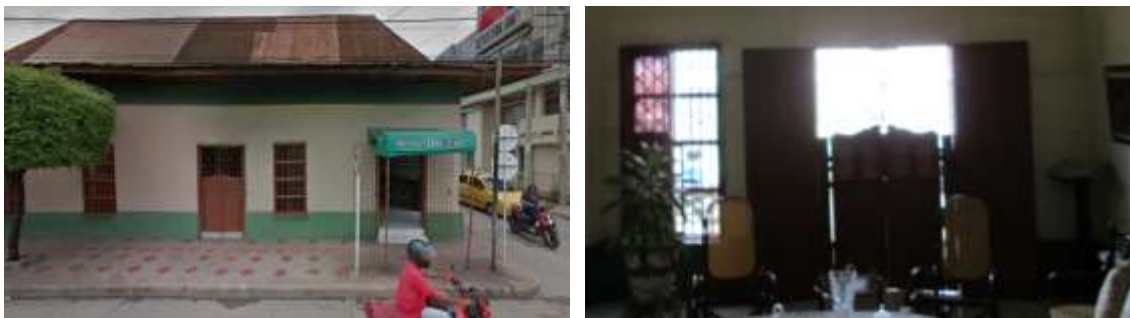
Imagen 49. Puerta doble con puerta inferior en madera tratada y rejillas en hierro forjado casa familia Paternina.
