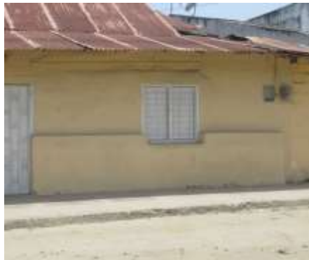
Imagen 57. Ventanería con hojas dobles, marco en madera y rejilla de seguridad en hierro casa de propietarios no identificados.
