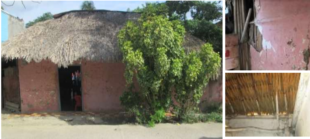
Imagen 119. Muros exteriores casa familia Paternina Anaya.
