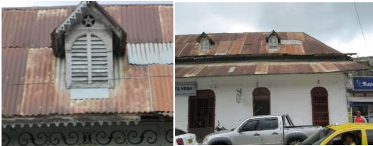
Imagen 29. Cubierta y mansardas de Casa familia Vélez.
