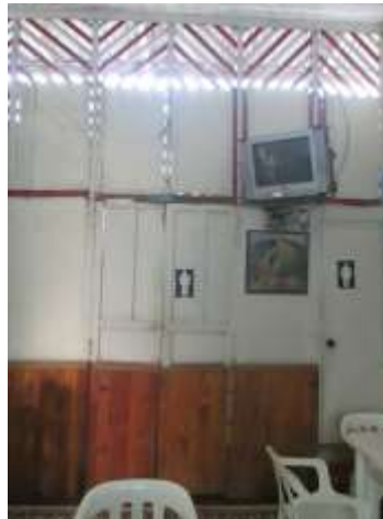
Imagen 51. Rejilla de ventilación en listones de madera casa familia Cáceres.
