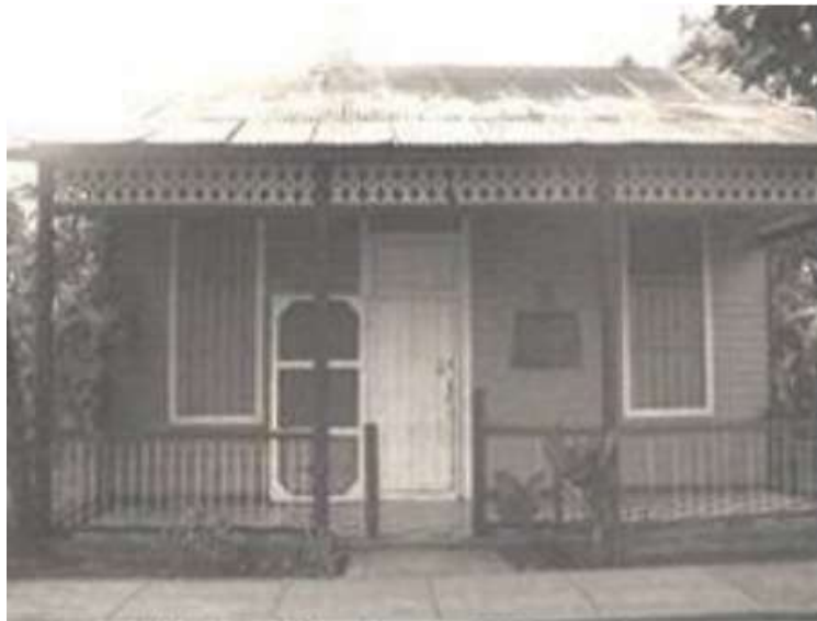
Imagen 8. Vivienda de obreros del central, tipología Ballon Frame. Recuperado de: Machado (2011). Apología a la ciudad Contramaestre: un breve estudio histórico-urbano
