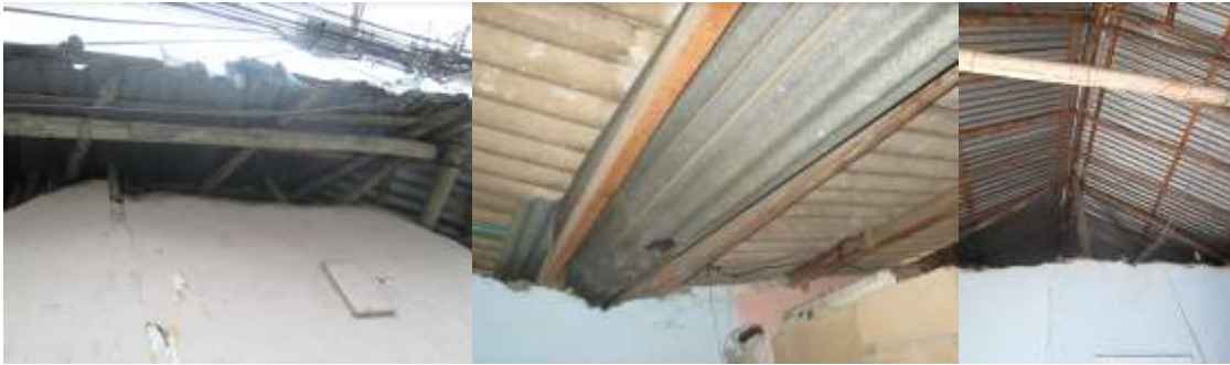
Imagen 61. Sin cielo raso exterior e interior casa familia Villamizar
