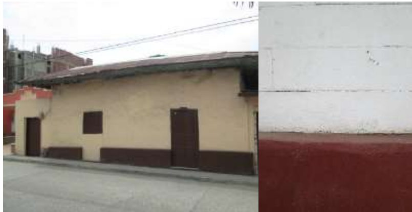
Imagen 39. Zócalo en hormigón con distinta pintura a fachada principal casa familia Vélez y casa familia anónima.
