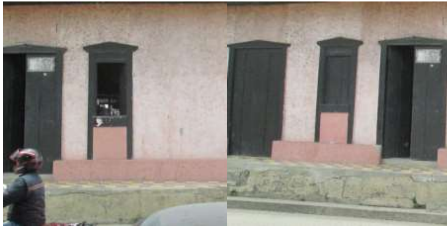
Imagen 55. Ventanería de hoja doble en madera casa de propietarios no identificados
