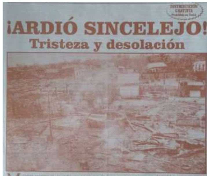
Imagen 16. Fotografía de Calle Real, uno de los sectores más afectados por la conflagración.
