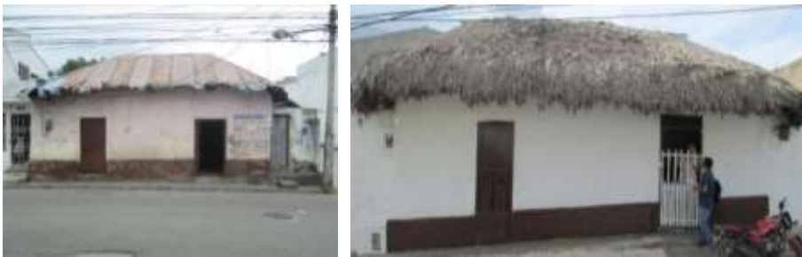
Imagen 32. Muros exteriores en bloque y hormigón casa familia Villamizar y casa Molina Márquez
