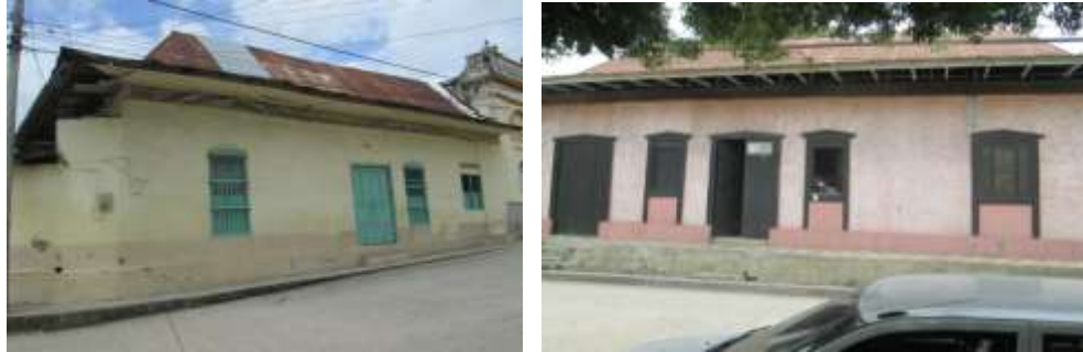
Imagen 48. Puerta doble en madera tratada casa familia Ruíz y casa de Propietarios no identificados.
