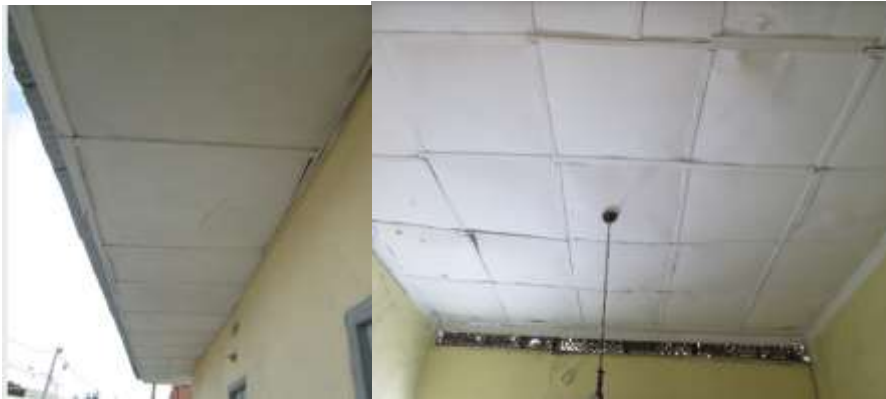
Imagen 62. Cielo raso exterior e interior en madera prensada casa familia Ruíz, y casa Familia Casillo
