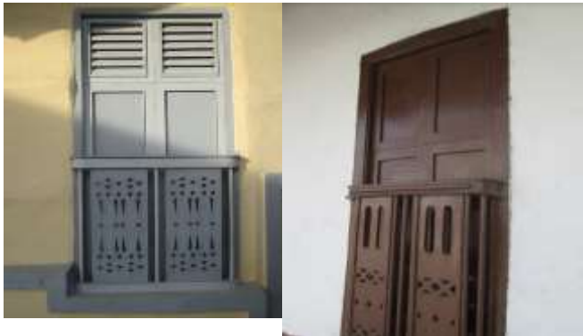
Imagen 56. Ventanería de cuatro hojas y balconería en madera tratada casa familia Molina y familia Casillo.
