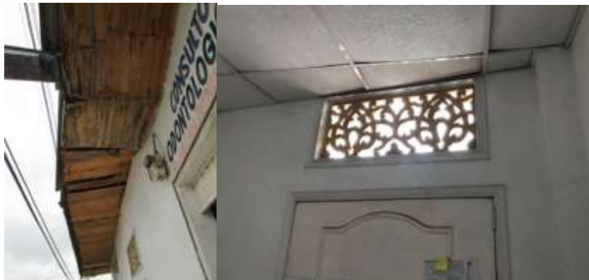
Imagen 131. Vivienda de la familia Fuentes, rasgos de la arquitectura antillana..
