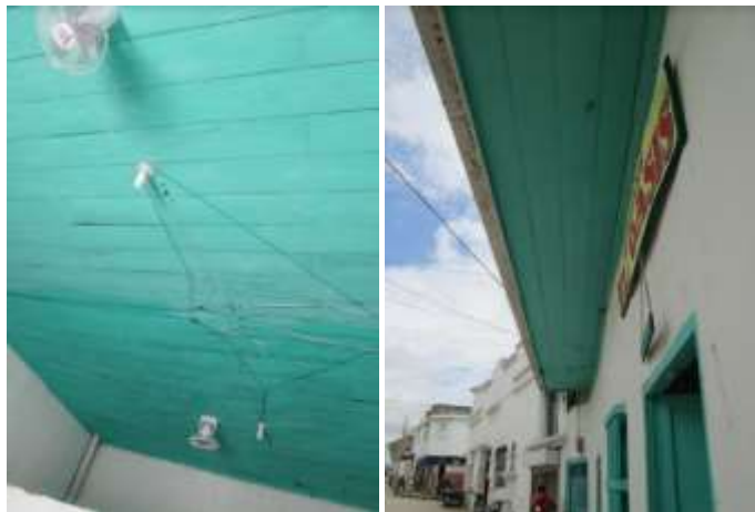
Imagen 59. Cielo raso exterior e interior en madera machimbre casa familia Fernández Camargo.
