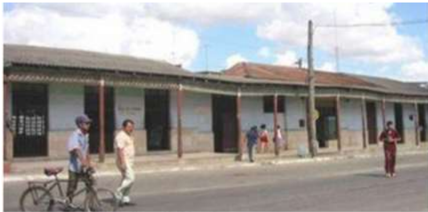
Imagen 7. Vivienda y portales públicos de comercios característicos de la arquitectura vernácula presente en Contramaestre.
