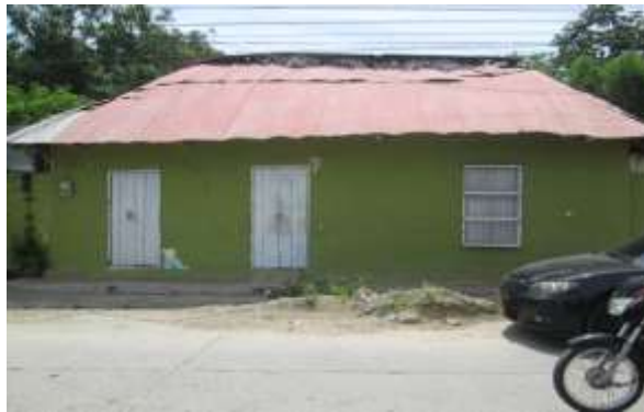
Imagen 50. Puerta simple en madera tratada casa de Propietarios no identificados.
