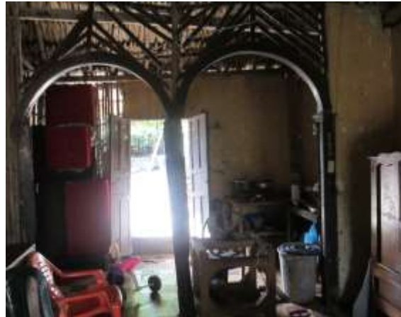
Imagen 67. Arcos en madera tipo listones casa familia Caldera.
