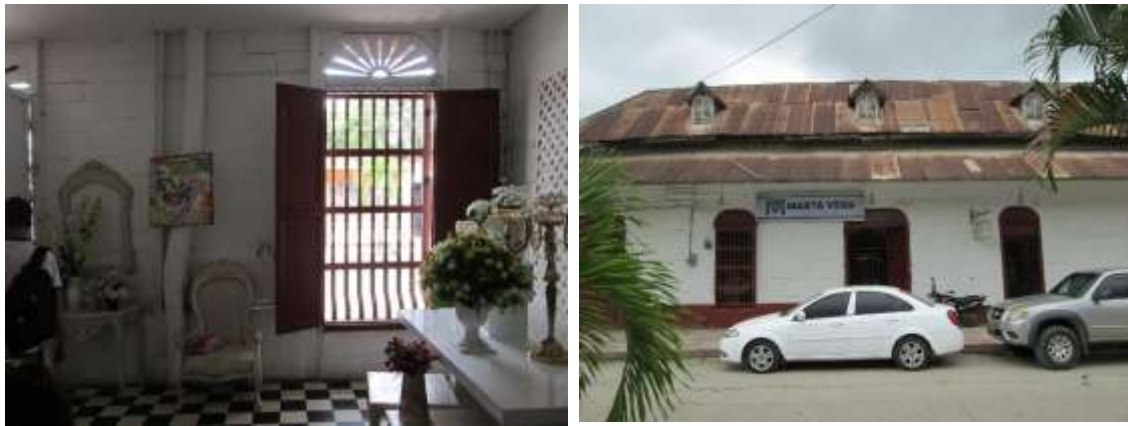
Imagen 35. Muros exteriores en madera tratada casa familia Vélez.
