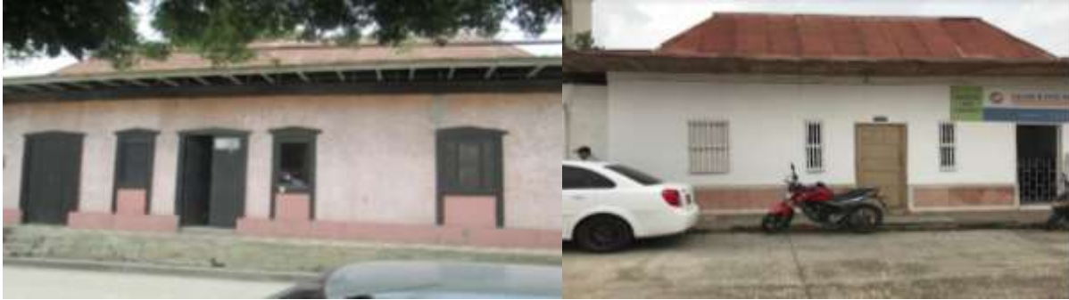
Imagen 41. Zócalo en hormigón con acabados casa familia Fuentes y casa propietarios no identificados.
