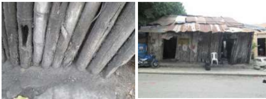
Imagen 34. Muros exteriores en bahareque sin pañete casa familia Caldera.
