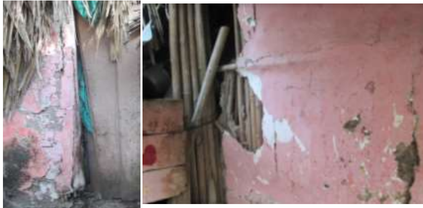
Imagen 33. Muros exteriores en bahareque y boñiga de vaca casa familia Paternina Anaya.
