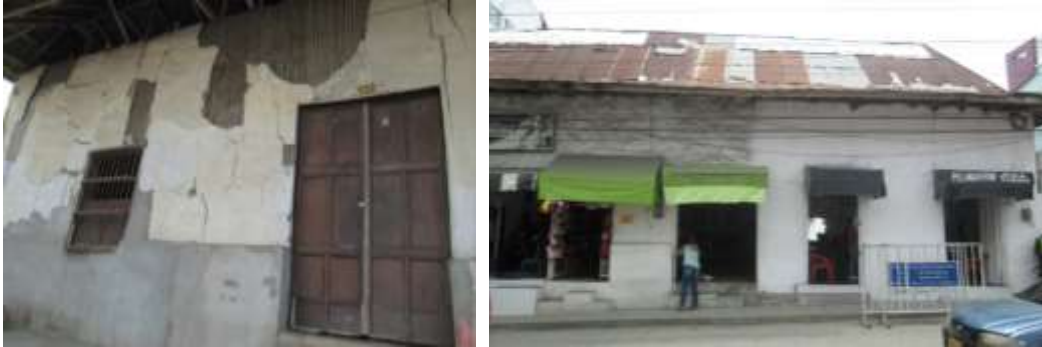
Imagen 31. Muros internos en bahareque y hormigón casa familia Vergara y casa Propietario anónimo.
