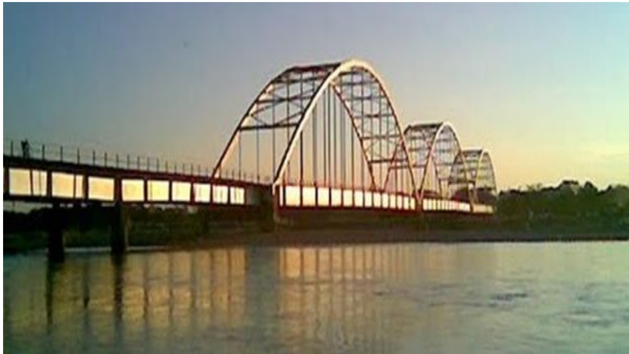
Puente el Alcaraván, municipio de Granada.
